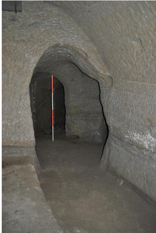
Abbildung 19: Blick von Gang 5 auf den Zugang zum Eis Lager (geradeaus) und zum Gang 6a (vor der Messstange rechts) mit einer bemerkenswerten Ausbuchtung (r.), dank der offensichtlich der spitze Winkel von Gang 5 zu Gang 6a besser passiert werden konnte (vgl. Abbildung 10).
