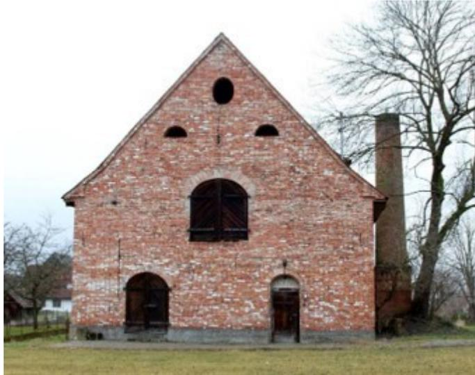
Abbildung 28: Östliche Giebelseite des nach dem Brauereibrand 1909 teilweise wiederaufgebauten Brauereigebüdes mit dem im rückwärtigen Teil erhaltenen Eiskeller
