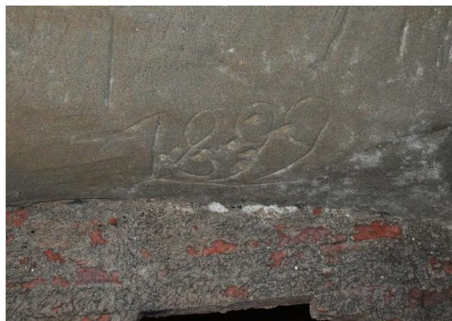
Abbildung 24: Jahreszahl 1899 über dem Eingang zu Gang 2a (darunter das Mauerwerk, mit dem im 2. Weltkrieg der einzelnen Kellerabteilungen abgetrennt wurden).
