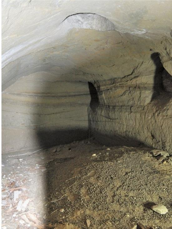
Abbildung 11: Blick in die Eiskammer (Eis Lager) mit Einfüllöffnung an der Decke und Lüftungsschächten (r.) an ihrer nördlichen Wandseite<sup>17</sup>
