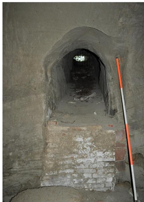
Abbildung 16: Westwärts gerichteter Lüftungsschacht im Gang 7
