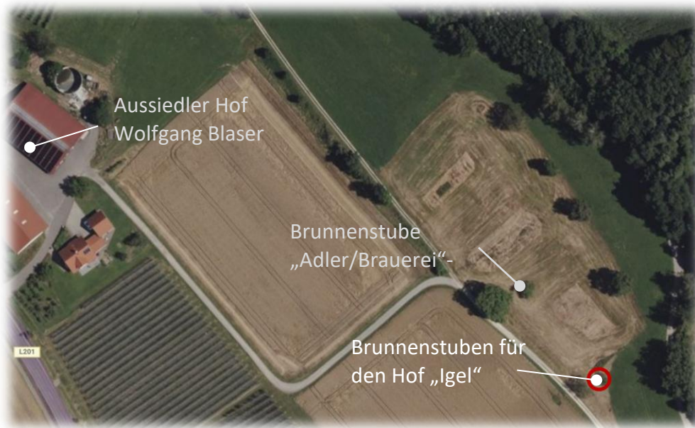
Abbildung 12 Quellgebiet für die Wasserversorgung des Lehenhofs „Igel“ sowie für das Anwesen Jegle/Dierberger.
